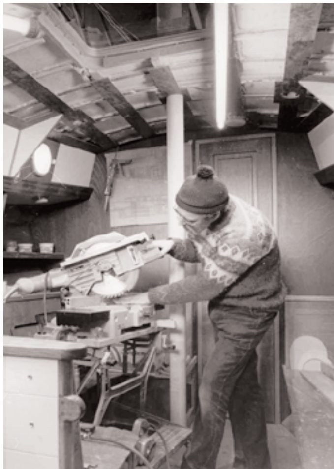
Bij het intimmeren is het belangrijk dat alle zaagsel goed wordt opgevangen en niet onder de vloer terecht komt.
